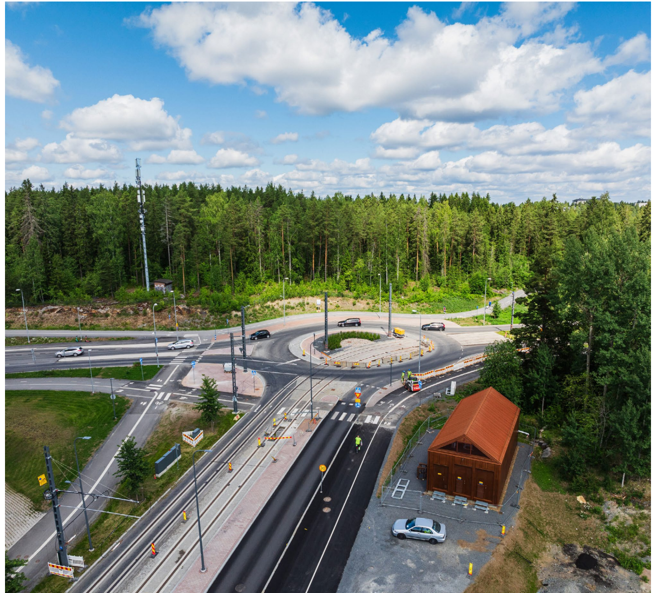
Raitiotie ja sähkönsyöttöasema Kehyskadun ja Lielahdenkadun kiertoliittymän läheisyydessä Lentävänniemessä. Kuva: Raitiotieallianssi / Pasi Tiitola.
