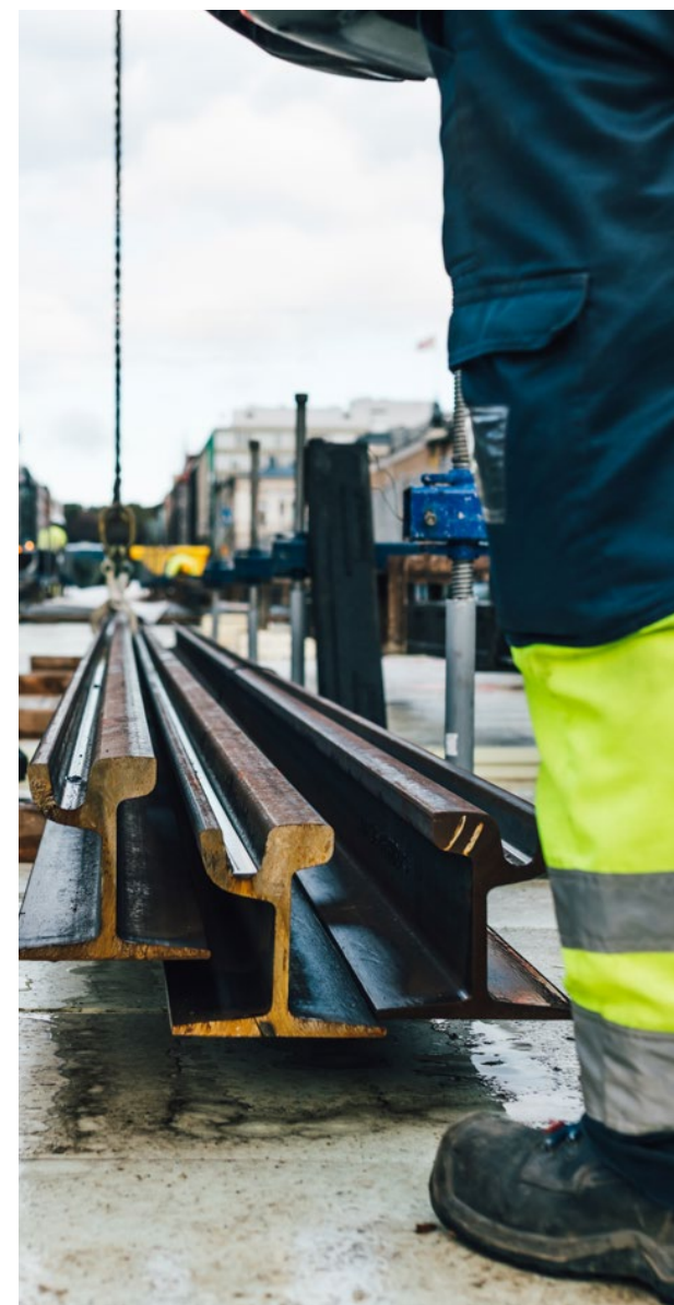
Kiskojen asennusta Hämeensillalla keväällä 2020. Kuva: Raitiotieallianssi / Wille Nyssönen.
